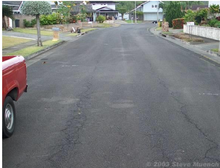
LONGITUDINAL CRACKING
